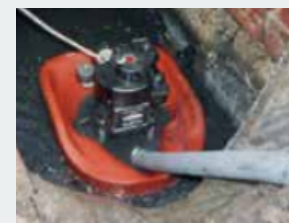
EXTRACCIÓN DE AGUA DESDE POZOS
